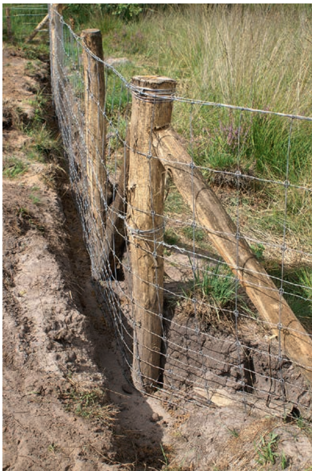
FIGUUR 3 Raster van eikenhouten palen met zwaar ursusgaas (breedte 120 cm) dat ongeveer 40 cm in de grond is ingegraven (foto: A. Lenders).
